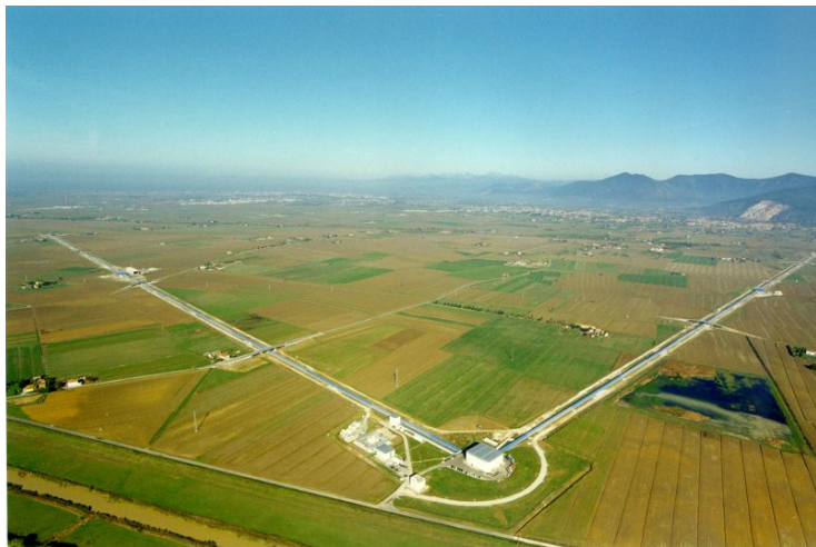
Détecteur interférométrique VIRGO sur le site de Cascina, près de Pise [CNRS/INFN]
