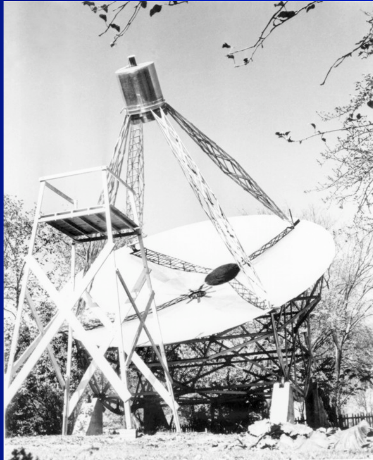
1940: radiotélescope de Reber construit dans son jardin à Chicago
