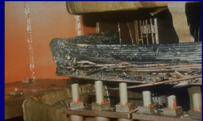
Transformateur d'une centrale nucléaire US brûlé le 13 mars 1989.
